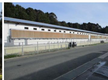
入気部分にはクリーンパットが取り付けられており、夏場は「中水」（膜濾過水）の気化で外気を冷やし入気
