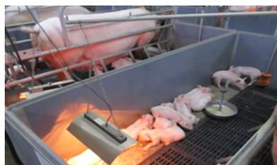
哺乳子豚にはガスヒータを使わず、温湯配管による床暖房とコルツヒータ使用
