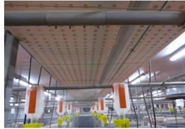
スリットから入ってきた空気は、天井下に設置した「デルタパイプ」(アルミ板の温湯配管)で温められてから下に降りてくるため、分娩舎内全体がむらなく温まるようになっている
