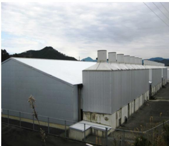
すべての豚舎に完備している「3段階脱臭システム」。舎内の空気は3つのフィルターを通過後、チムニーから排気される
