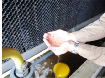
豚舎側面に平行してプラスチック製の2つのフィルターユニットが設置されており、その下の水槽に貯められた「中水」をポンプでくみ上げフィルターに噴射しながら埃の除去とアンモニア水溶を行う
