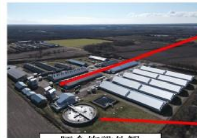
豚舎施設外観
